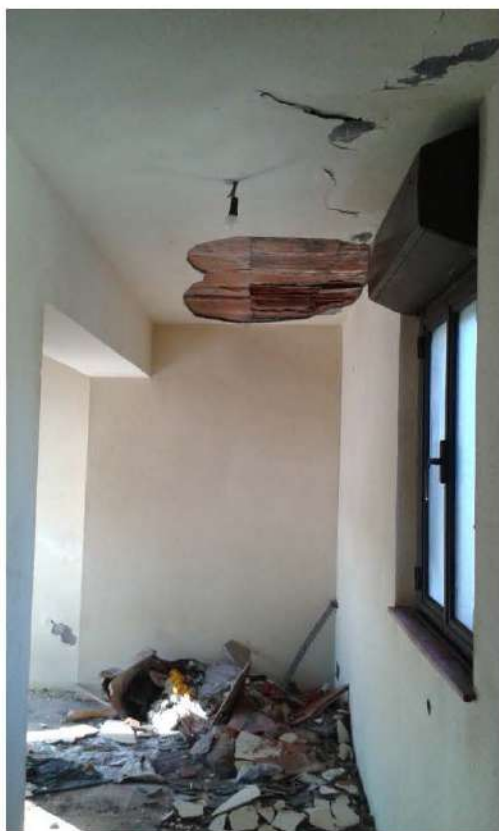
Foto 41: Piano soffitta: Vista parziale del locale di sgombero
