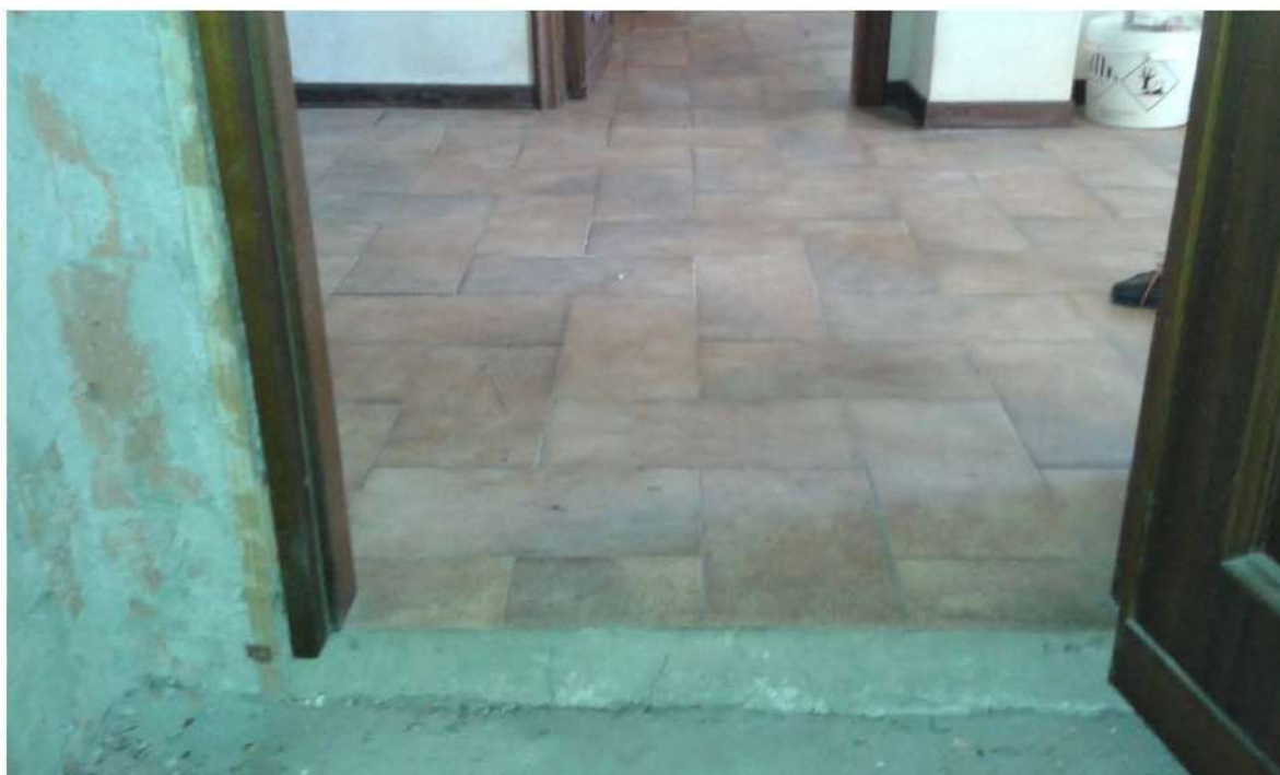
Foto 49: Piano rialzato: Particolare della pavimentazione del piano
