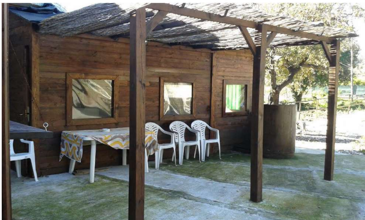
Foto 57: Piano rialzato: Strutture in legno per realizzazione di altra struttura con pergolato rimovibile sul prospetto Ovest
