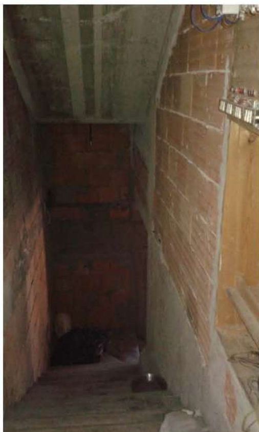
Foto 45: Piano rialzato: Rampa di scale che conduce al piano seminterrato
