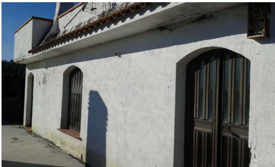
Foto 42: Piano soffitta: Vista prospetto Est
