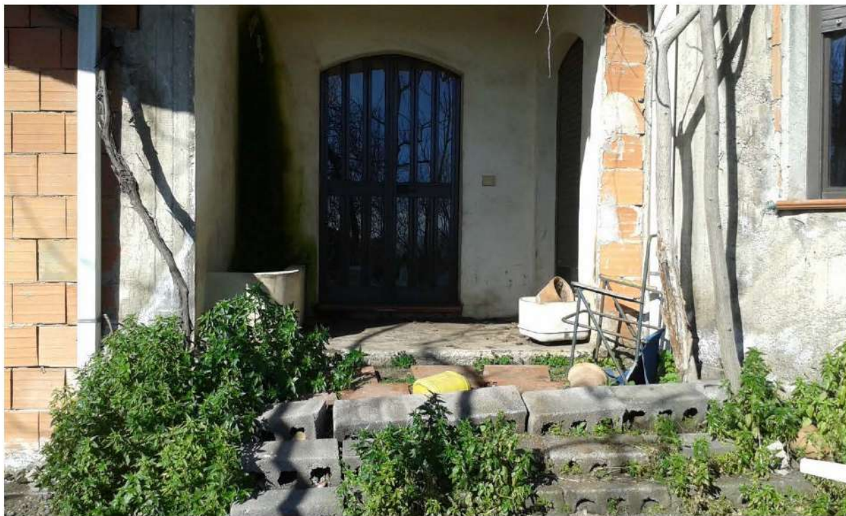
Foto 12: Ingresso principale della villa
