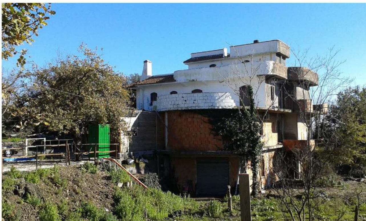
Foto 11: Vista Sud – Ovest
