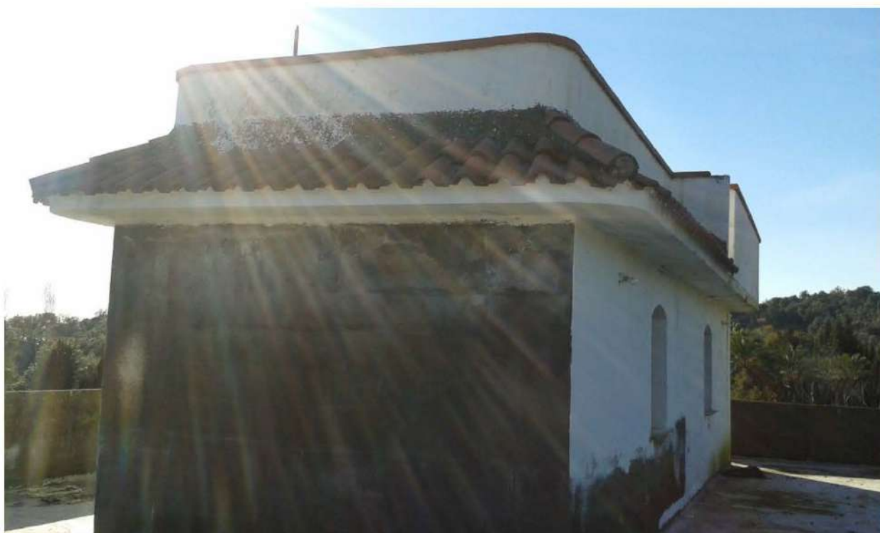
Foto 43: Piano soffitta: Vista Nord-Ovest
