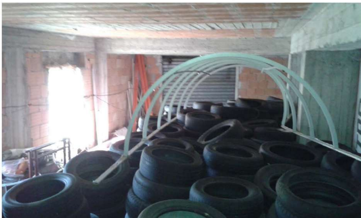
Foto 46: Piano seminterrato: Ampio garage
