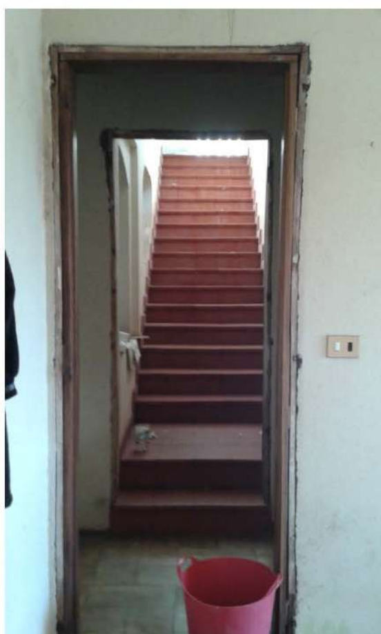
Foto 39: Piano primo: Rampa di scale che conduce al piano soffitta
