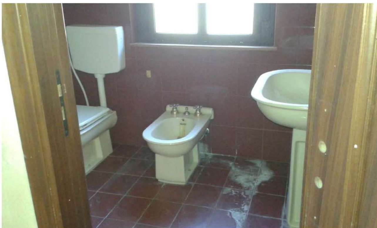
Foto 35: Piano primo: Bagno con affaccio a Nord
