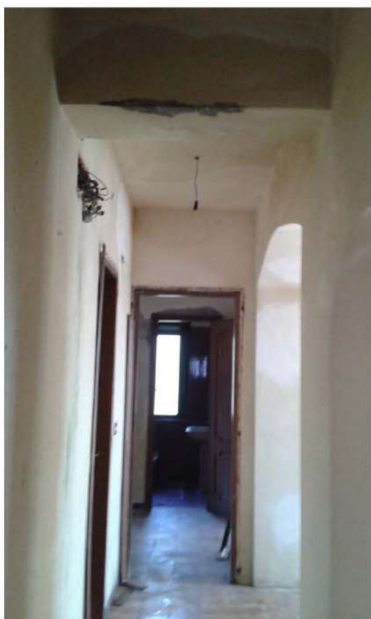
Foto 31: Piano primo: Corridoio
